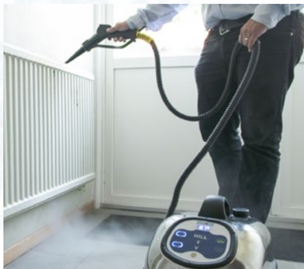
Utrymmen bakom element är riktiga dammsamlare. Med ånga får man bort dammet och binder det på samma gång.
