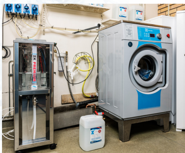
Med nyinstallerade Z-Water Generator och tvättanläggningen klarar man nästan alla tvättbehov utan att använda tvättmedel.
